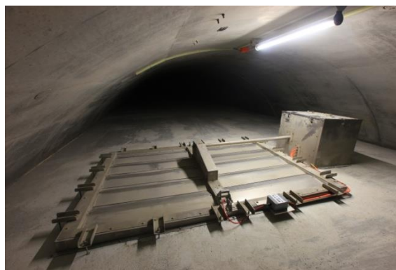
Canal de ventilation avec clapet
