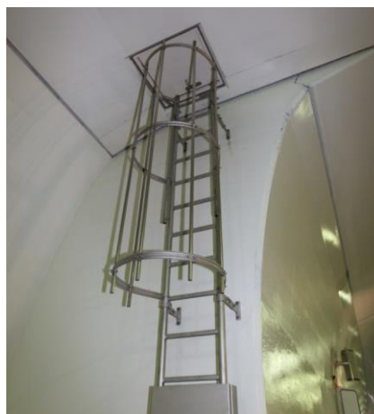
Echelle d'accès au canal de ventilation
