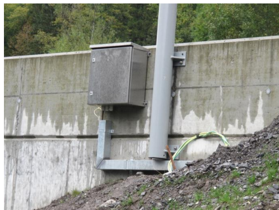
Mât caméra avec boîtier de commande
