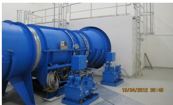
Centrale de ventilation (Intérieur du ventilateur : catégorie de corrosivité C5)
