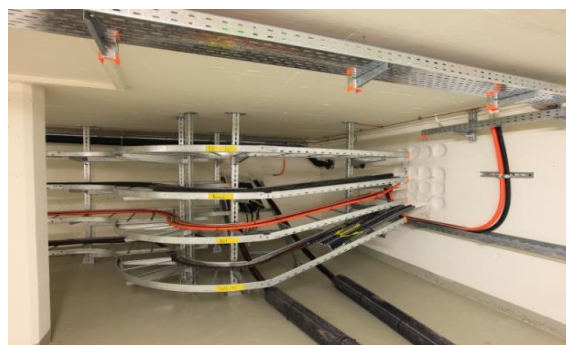
Gaine technique avec chemin de câble
